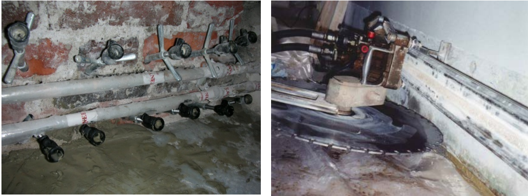
Kuva 4. Injektoinnilla ja mekaanisesti sahaten tehty kapillaarikatko. (Kuvat: Tiina Palviainen, Vahanen Oy)
