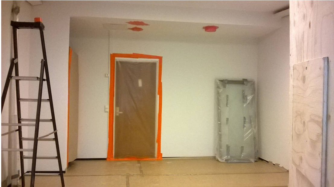
Kuva 6. Suojaukset ovat olennainen osa pölynhallintaa (Kuva: Esko Sistonen).
