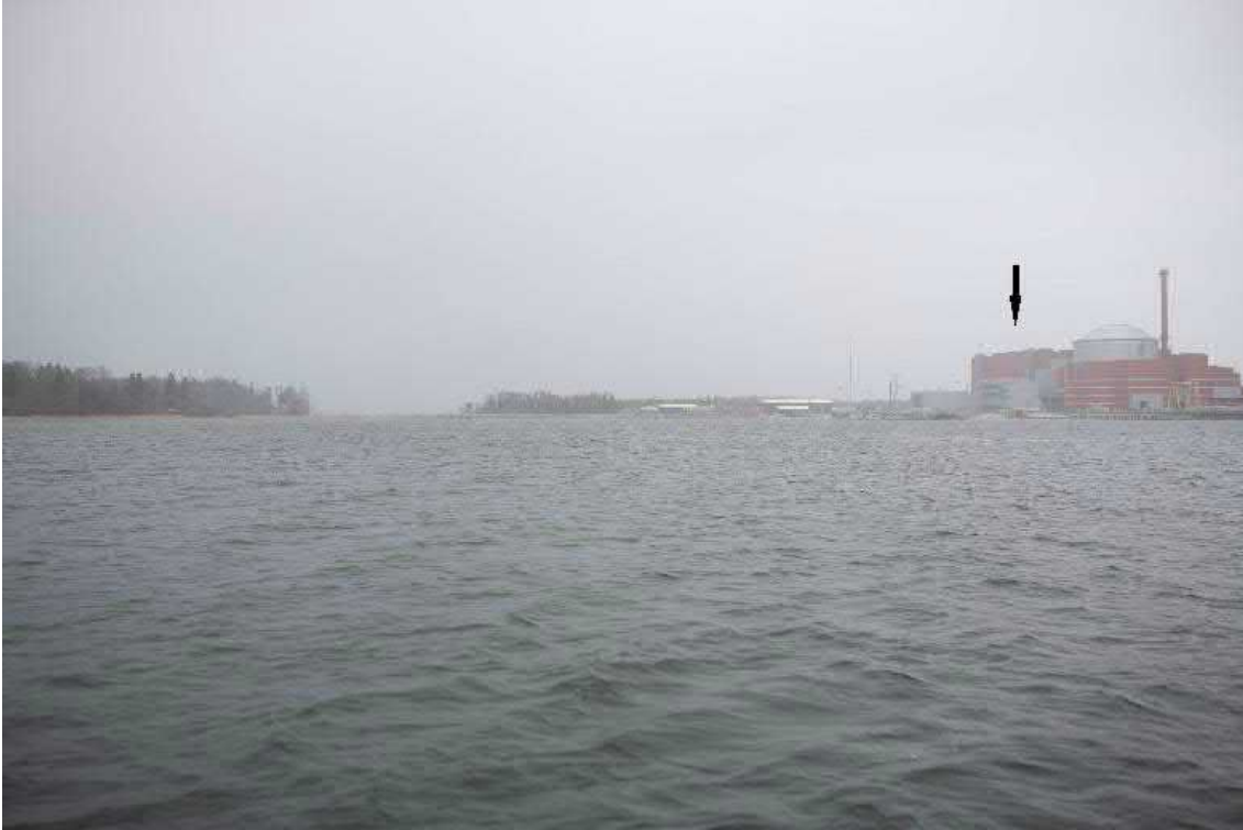
Kuva 7-7. a, b ja c. Ylimmässä kuvassa valokuviasovite, jossa on esitetty suunniteltu rakenne vaihtoehdossa 1, keskimmaisessä kuvassa vaihtoehdossa 3 ja alimmassa kuvassa vaihtoehdossa 4. Kuva on otettu pohjoiseen Nousiaisen edustalta ja rakenteen sijainti on osoitettu kuvassa nuolella. Lähde: TVO
